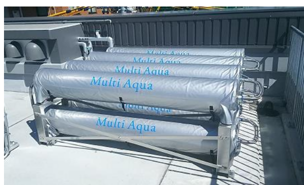
<屋上に設置された大容量貯水タンク「マルチアクア」>
